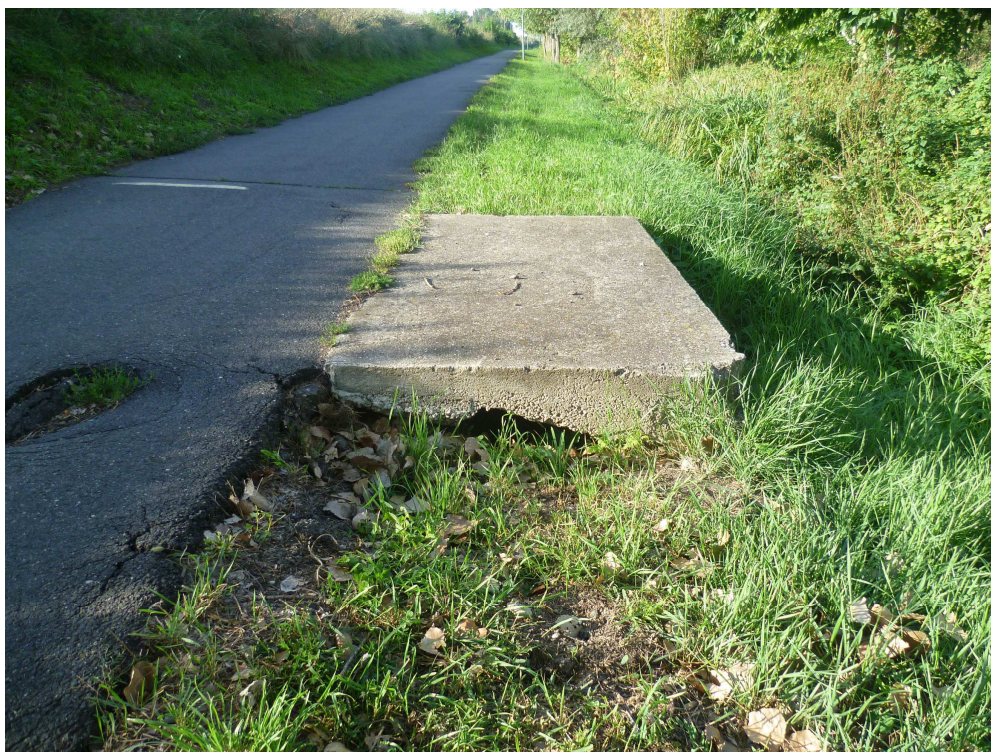
Pohled na čelní zídku výtoku propustku pod cyklostezkou
