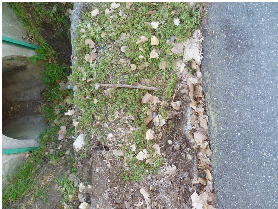
Pohled na překrytí vtoku propustku pod cyklostezkou
